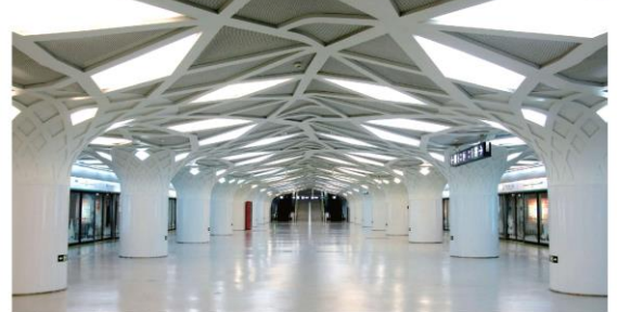
北京地铁8号线二期工程 Beijing Metro Line 8 (Phase II)
